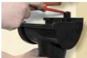
закрепите соединитель желоба и воронку на стене, также учитывая наклон 3 мм
