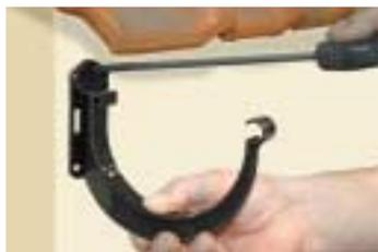
закрепите крайние кронштейны с учетом наклона по направлению слива 3 мм
