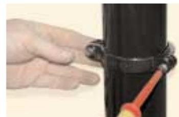
зафиксируйте трубу с помощью хомута
