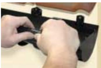
зафиксируйте желоб в соединителе и воронке
